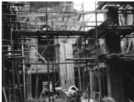
Eine gewaltige Aufgabe: Die ersten Gerüste zum Wiederaufbau stehen.
